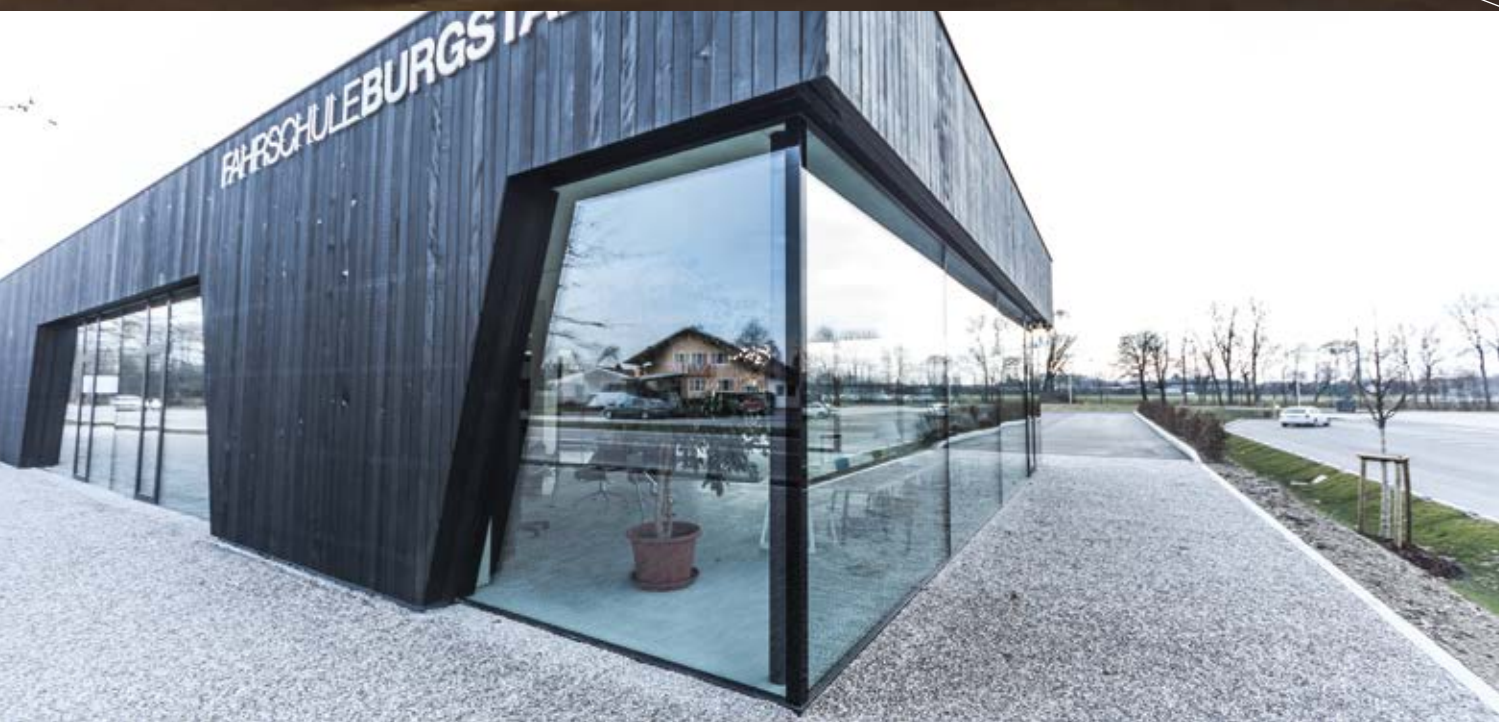
Polygonale, schräge und gerade Nurglaselemente in Kombination mit modernen Fassadenelementen
